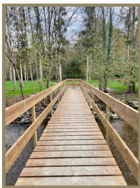
Passerelle sur la Petite Creuse à Malval
