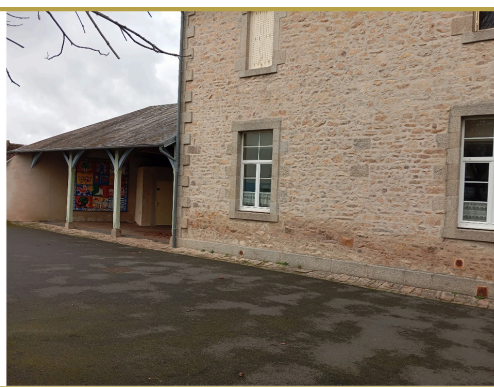
Cour qui va être réfectionnée en octobre 2025
