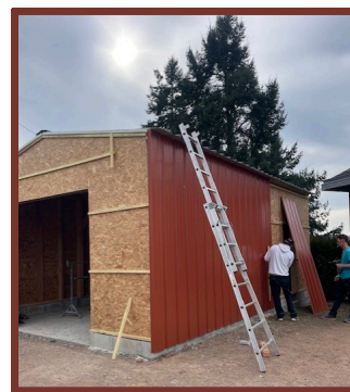
Construction du garage des sapeurs pompiers à Châtelus
