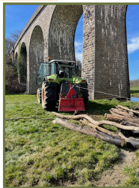
Travaux d'entretien des rivières à Genouillac
